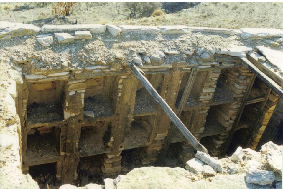
“Μελισσοκήπι” - Άνδρος. Τα «ντουλάπια» φαίνονται καθαρά, αφού η οροφή έχει καταρρεύσει Φωτ. Γ. Σπέης)
