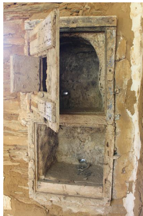
“Μελισσοκήπι” - Άνδρος. Τα «ντουλάπια» φαίνονται καθαρά, αφού η οροφή έχει καταρρεύσει Φωτ. Γ. Σπέης)
