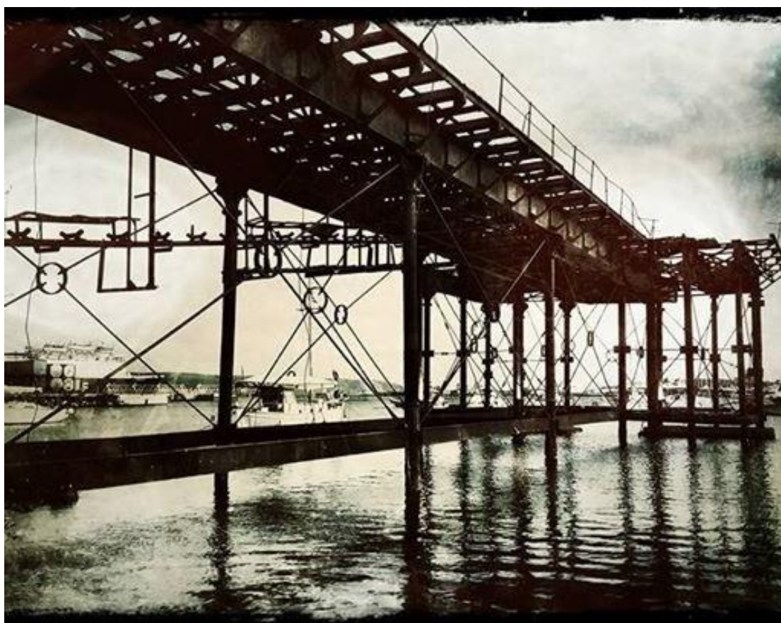
Φωτογραφική Απεικόνιση : «Σκάλα Φορτοεκφόρτωσης Μεταλλευμάτων της ΓΕΜΛ» Χρονολογία Κατασκευής 1888
